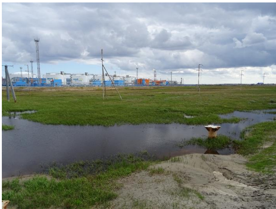
Рисунок 2.2-2. Участок подтопления вдоль автодорожной насыпи
