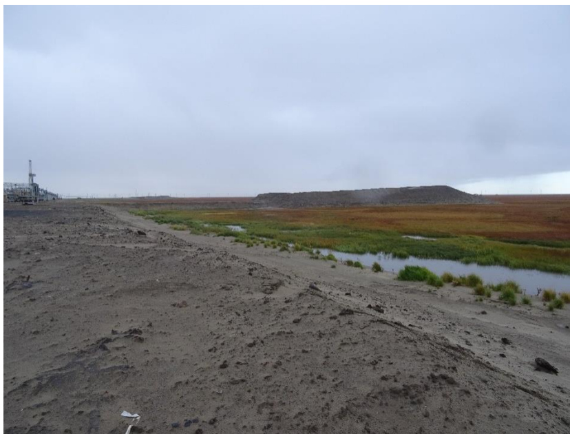
Рисунок 4.2-4. Подтопление тылового шва и денудационные процессы на отсыпке КП30
