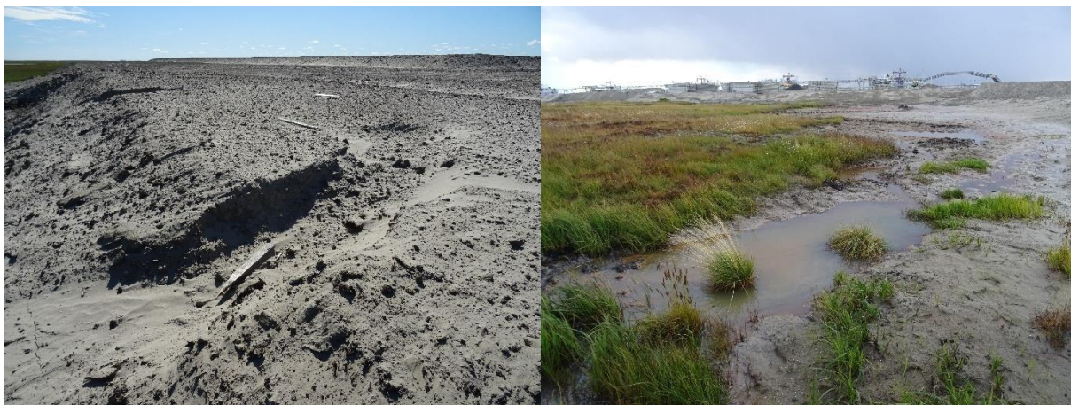
Рисунок 4.2-2. Подтопление тылового шва и денудационные процессы на отсыпке КП26
