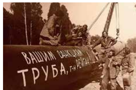
Строительство МГ «Уренгой – Помары – Ужгород»
